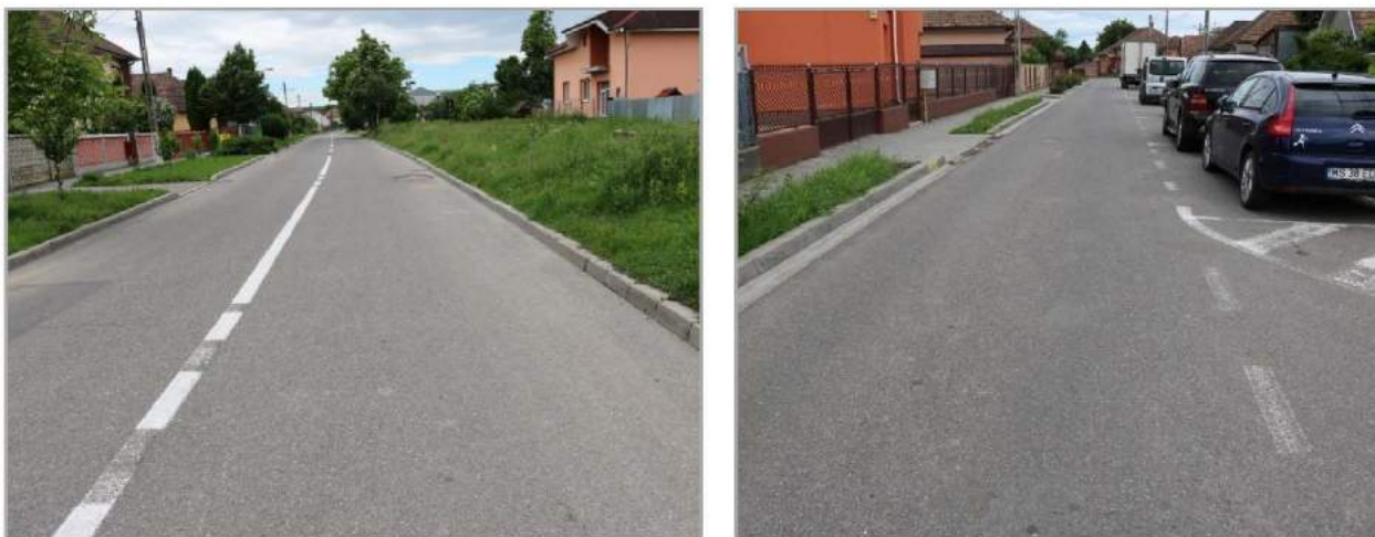
Figura 2.30. Străzi reabilitate/ modernizate – stare tehnică foarte bună (Str. Rozelor, Str. Libertății).
